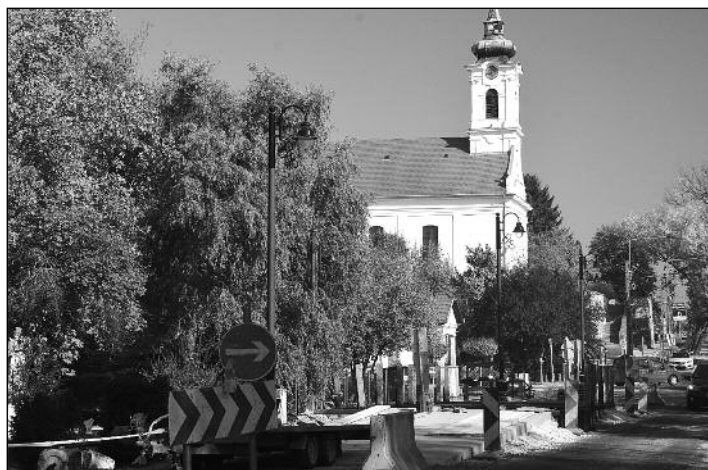
Hídépítési munkálatok a Magyar-kútnál
