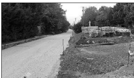
Aszfalt burkolatot kap az Öreghegyi út
