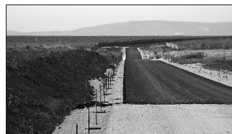
Gőzerővel folyik a kerékpárút építése a váli úton
