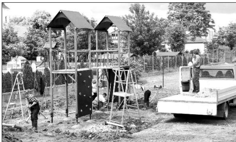
Megvalósult az iskola szülői munkaközösségének álma: készül az iskolai játszótér. Munkában az Accer Kft. munkatársai.
